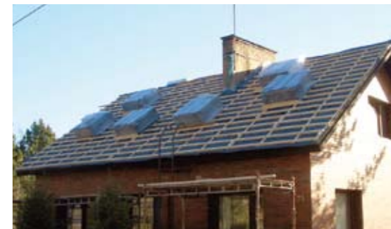
11 kappaletta puolilavoja ruoteilla. Tiileksi valittiin Ormax, jolta saatiin myös tiilille sopiva puolilavanosturi.
