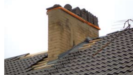
Piipunkin pintaan vedettiin tiilitasoitetta. Sen päälle piipun pintaan tuli pellitys.
