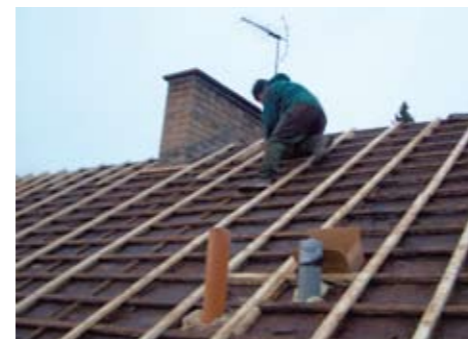
Tuuletusrimat aluskatteelle, vanhojen ruoteiden päälle.
