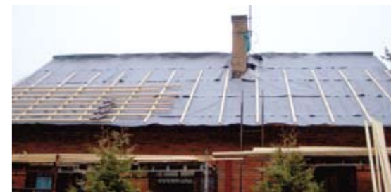
Aluskate, tuuletusrimat, ruoteet
