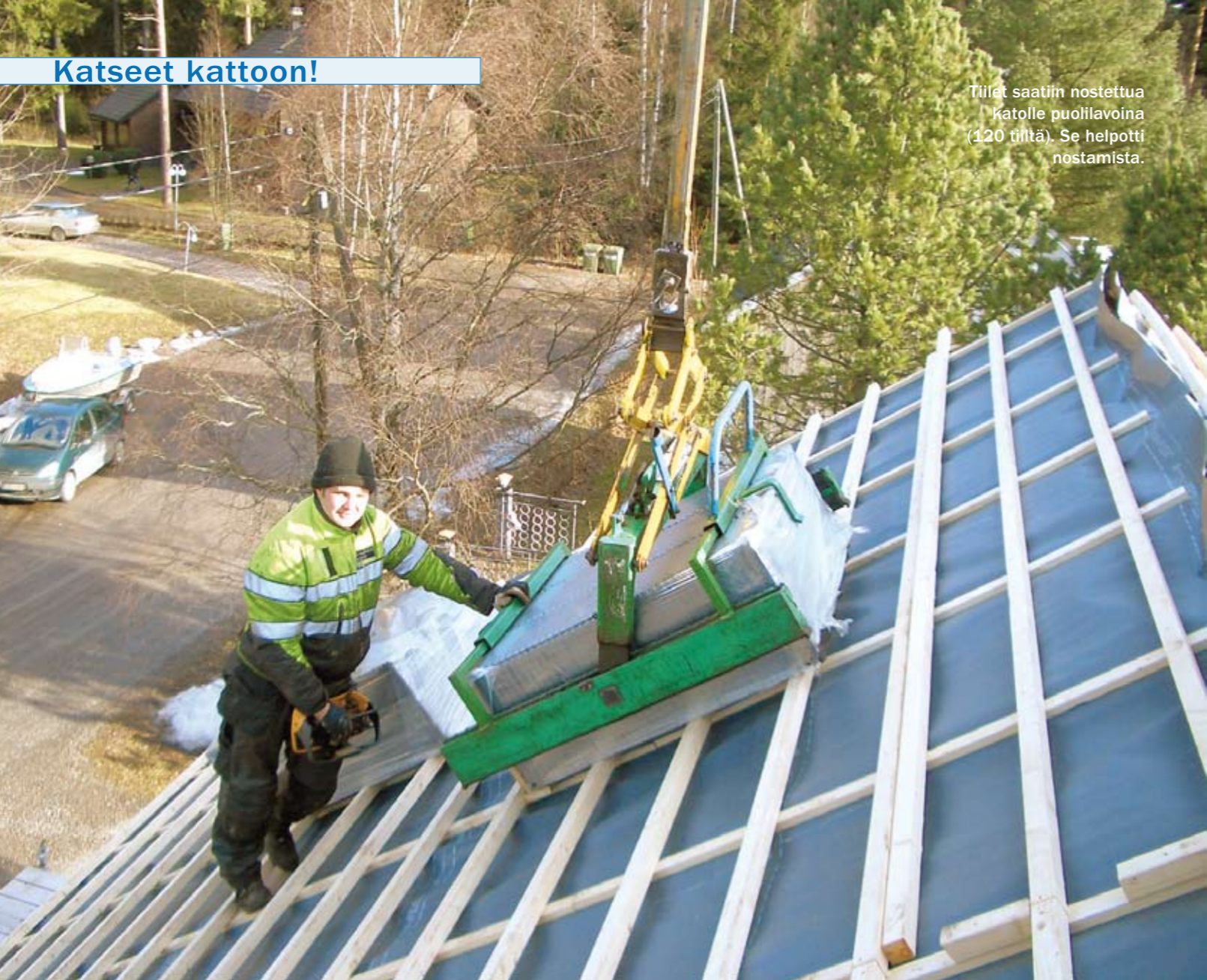
Tuuletusrimat aluskatteelle, vanhojen ruoteiden päälle.
